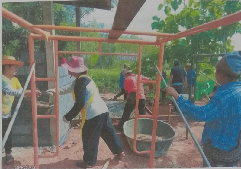
ภาพระหว่างก่อสร้าง
